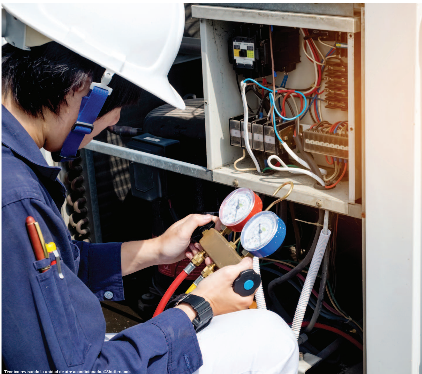
Técnico revisando la unidad de aire acondicionado. ©Shutterstock
