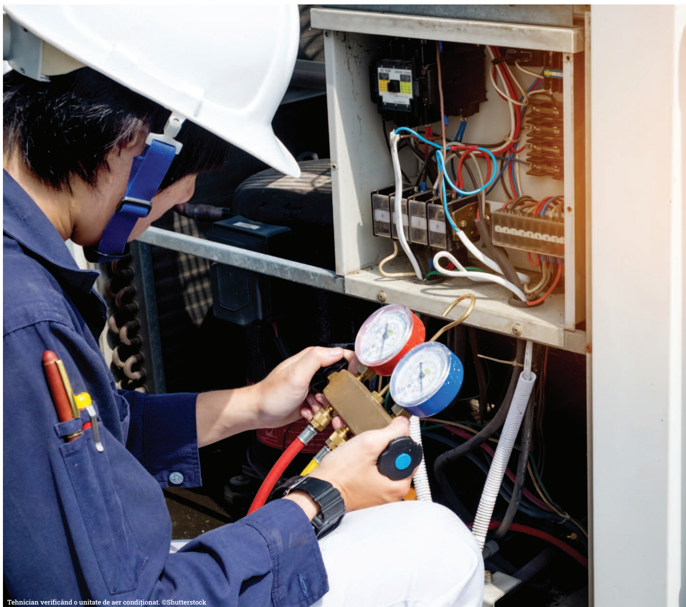
Tehnician verificând o unitate de aer condiționat. ©Shutterstock
